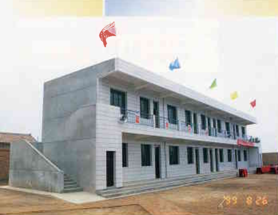
完成したばかりの校舍（教室棟）
